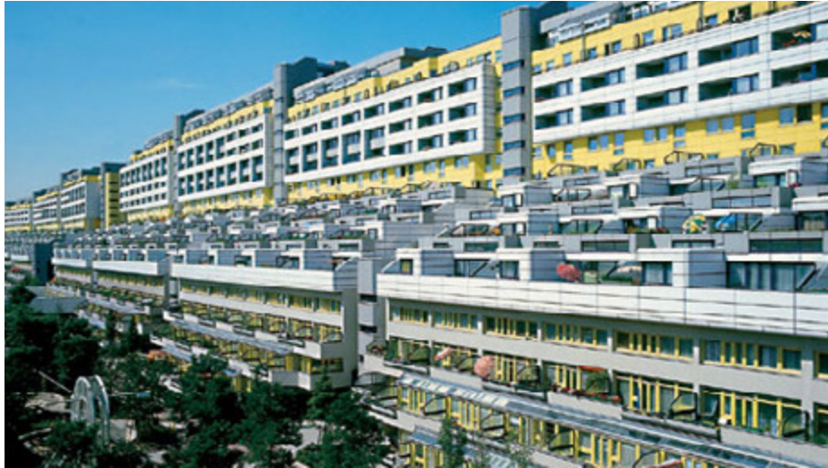
Wohnungsbau Schlangenhäuser Georg Heinrichs, Gerhard Krebs und Klaus Krebs, 1976-1980 Schlangenhäuser Straße 12-36, 14197 Berlin
