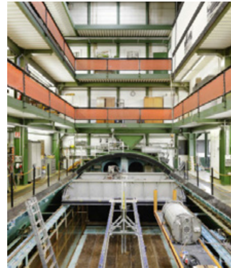
Innenansicht des Gebäudes
