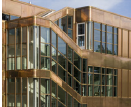
Außenansicht und Fassade
