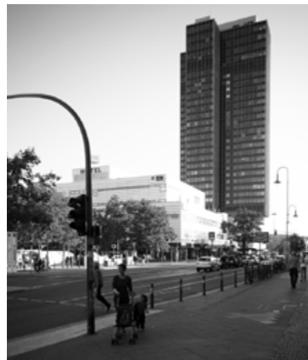
Foto Steglitzer Kreisel vor der Sanierung
